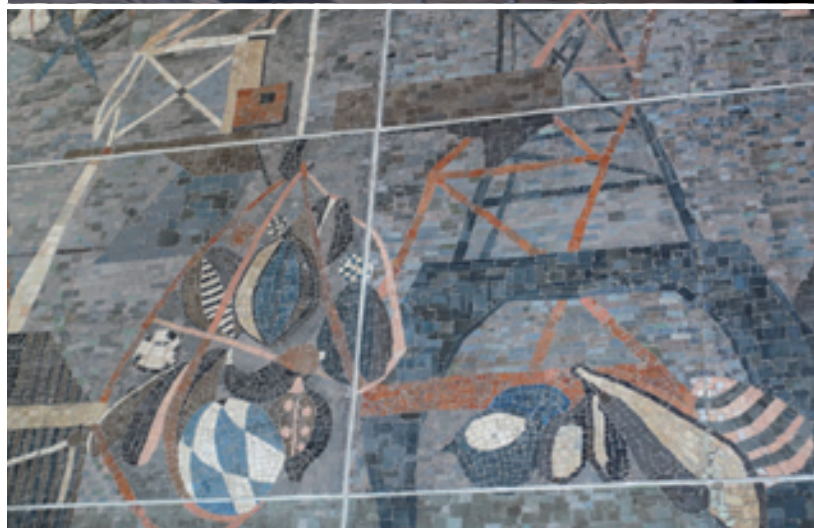
Od góry: Hala biletowa Dworca Głównego w Gdyni Mozaika ścienna dworca kolejowego
