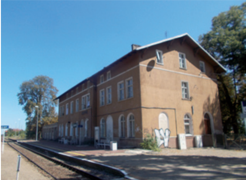
Budynki dworcowe w Witnicy (górze) i w Santoku
