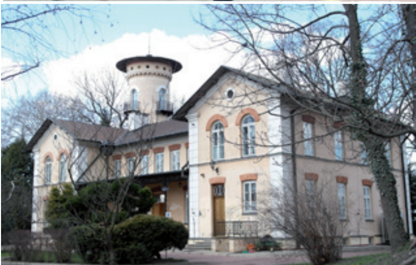
Od góry: Budynek dworca kolejowego w Grodzisku Mazowieckim (widok od strony torów) Jedna z odrestaurowanych willi
