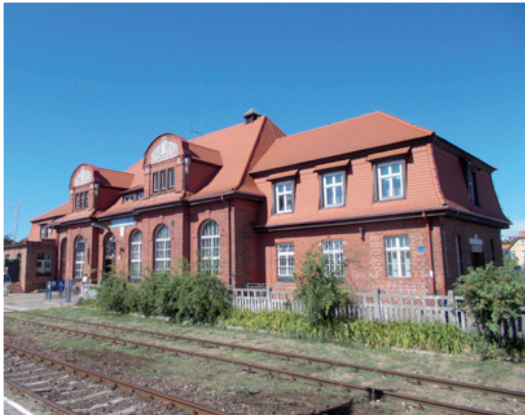
Dworzec kolejowy w Tucholi
